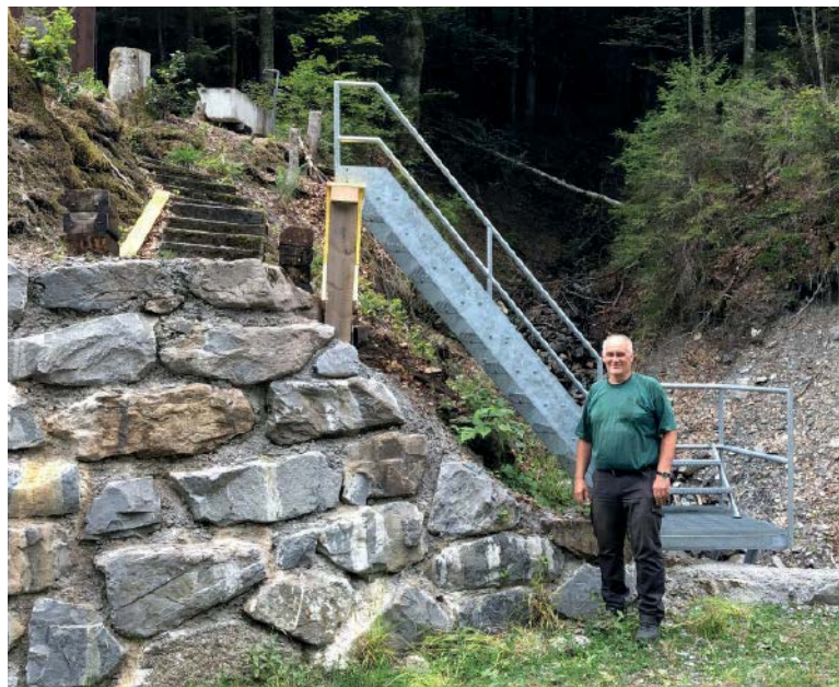
Das obere Bienenhaus bekommt eine angepasste Treppe
